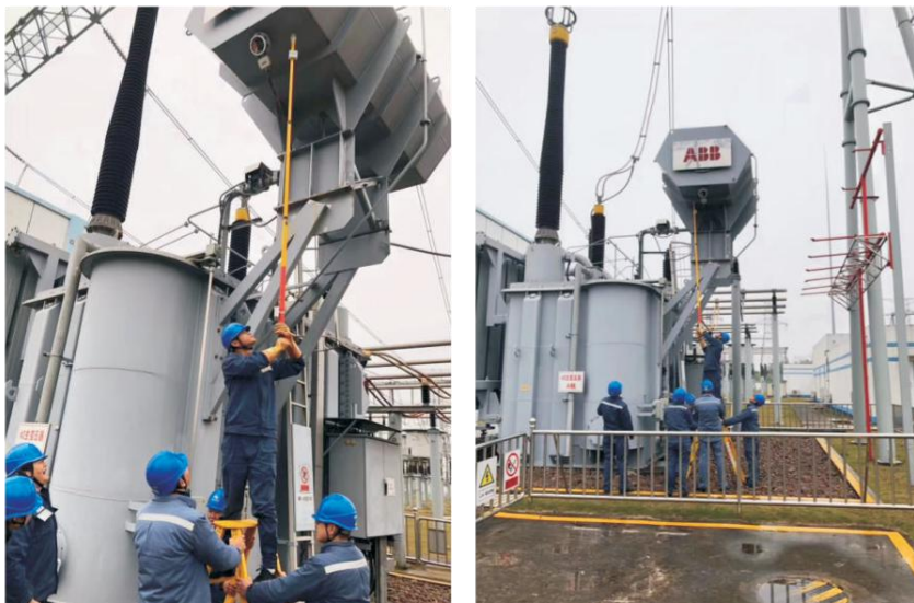
便携式油枕液位计测量示意图
